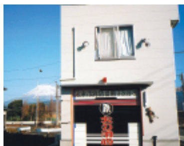
原植田に新しい地域消防の活動拠点ができました。
